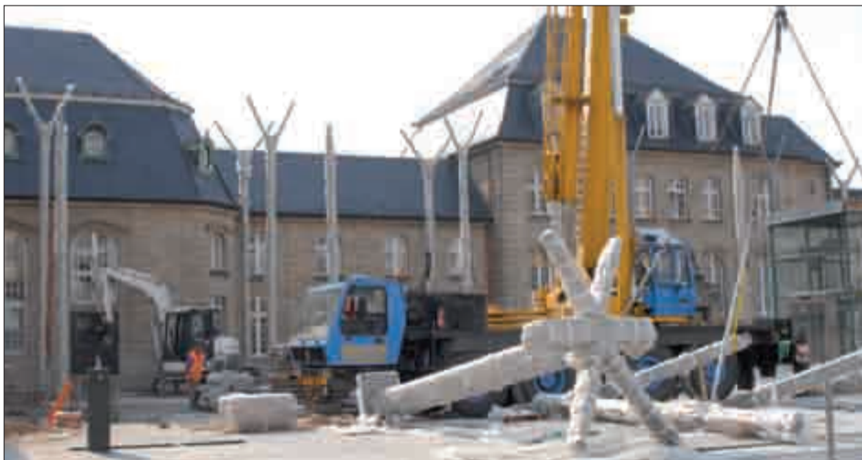
Die Modernisierung des Zentralbahnhofs Luxemburg geht in die Schlussphase
